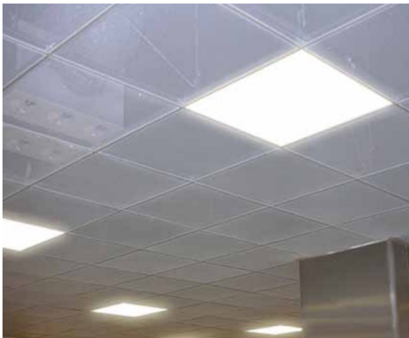
Esempio di tipologia del controsoffitto
