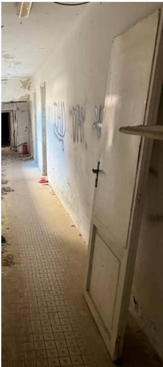
Piano seminterrato_ porta in legno
