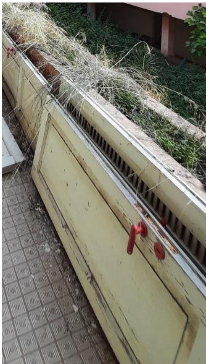
Piano terra_ porte interne precedentemente rimosse
