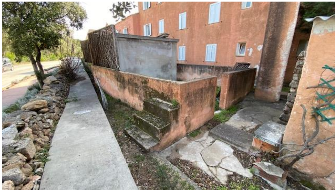
- Compresi muretti perimetrali e cisterne idriche -
