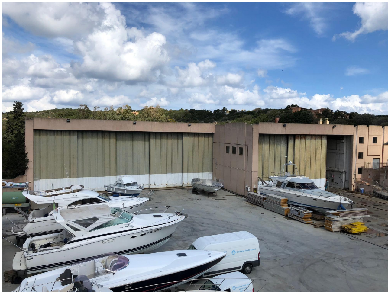
Portellone da ristrutturare
