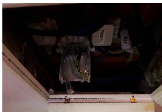
Foto 8. Botola aperta per ispezione controsoffitto
