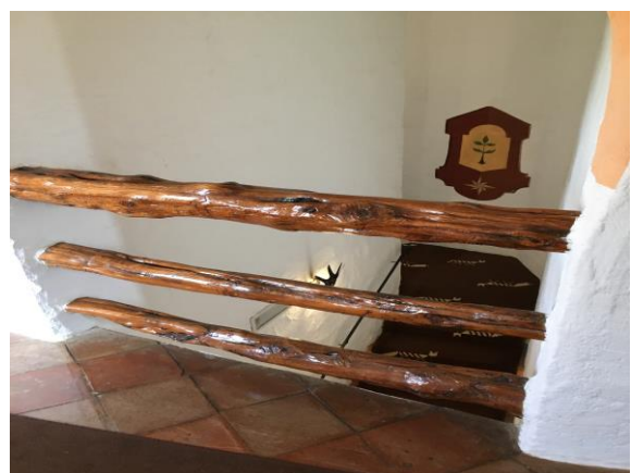
Foto 5. Corridoio / Parapetto in legno
