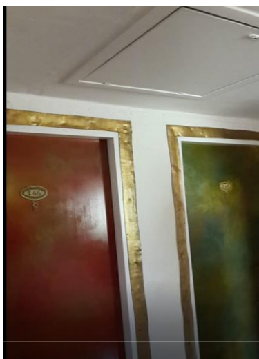
Foto 7. Botola per ispezione controsoffitto
